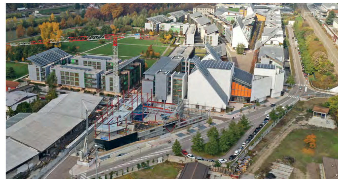
■ Lavori di costruzione del nuovo edificio ITAS Forum
